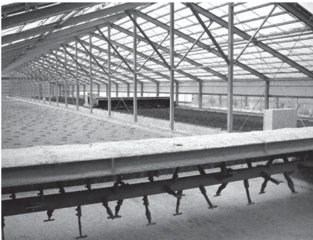
▲堆肥センター
