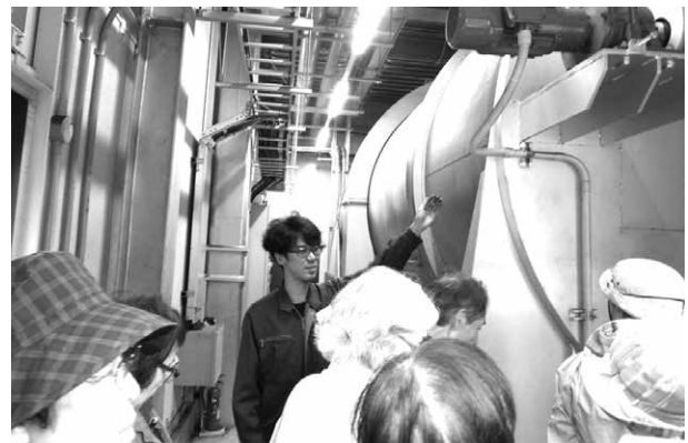
▲エコクリーンとうみの一次発酵装置
